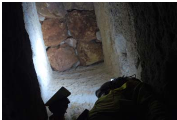
Pozo de ventilación y de extracción de material, que a su vez serviría para orientar la galería
