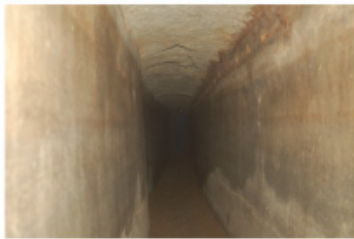
Galería-aljibe largo en la zona Sur (Obsérvese la conducción de cerámica en el lado superior derecho)
