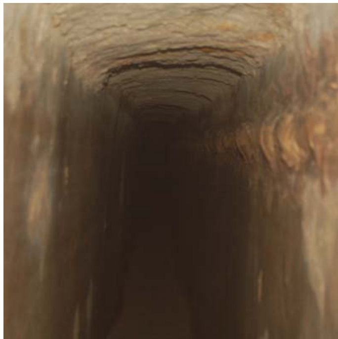
Galería de la cisterna
