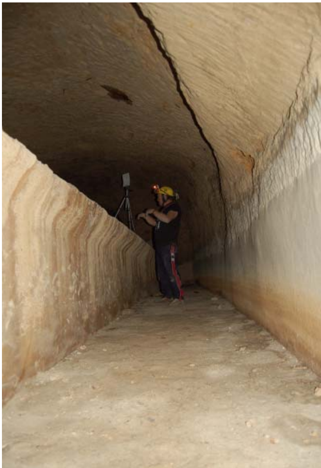
Canal de aliviadero
