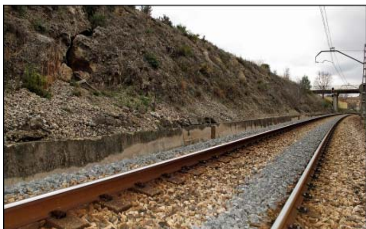
Vista de la trinchera del ferrocarril
