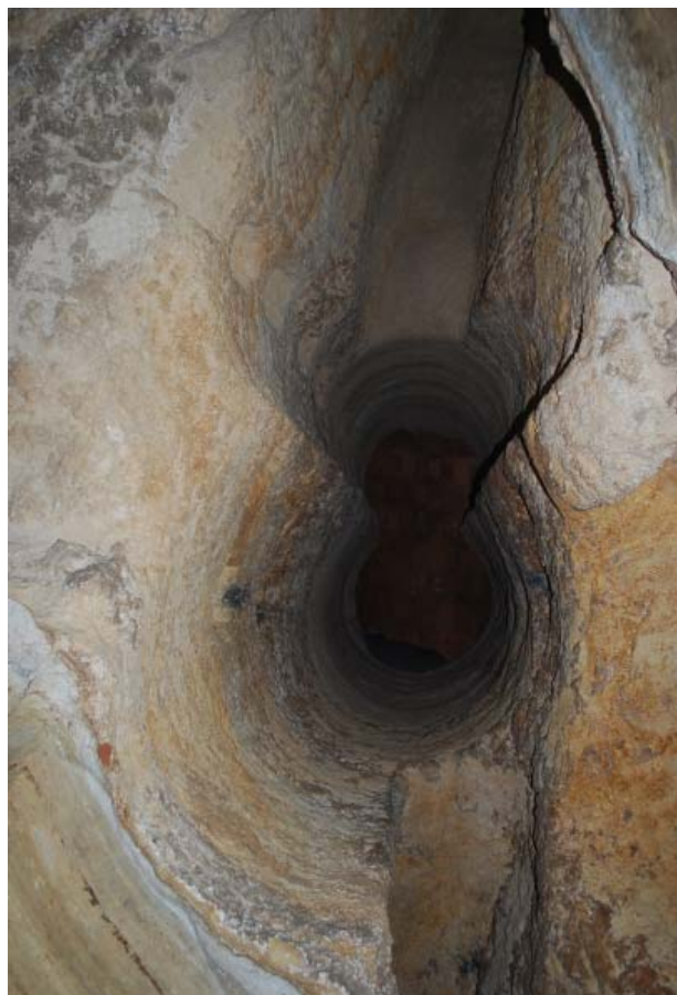
Techo de la cisterna de la noria, con su doble seno para el izado y descenso de los recipientes.
