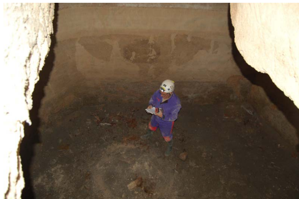
Panorámica de la cisterna
