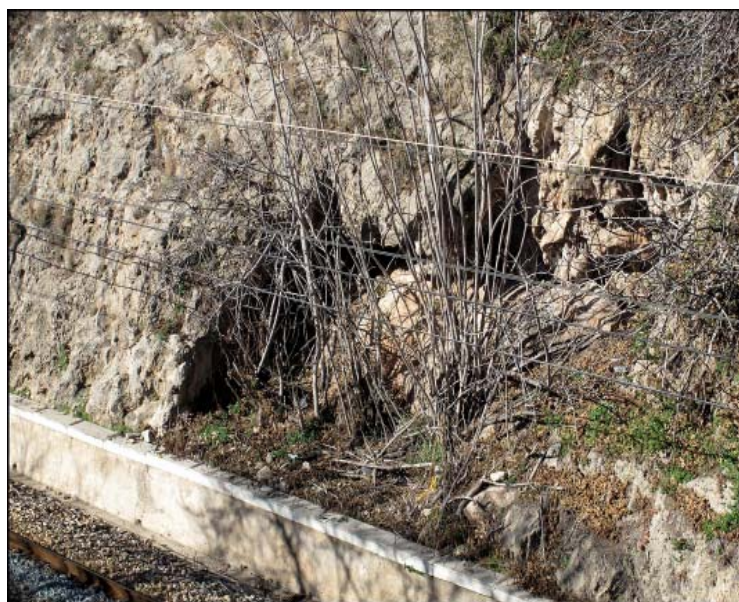
Acceso a la cavidad B
