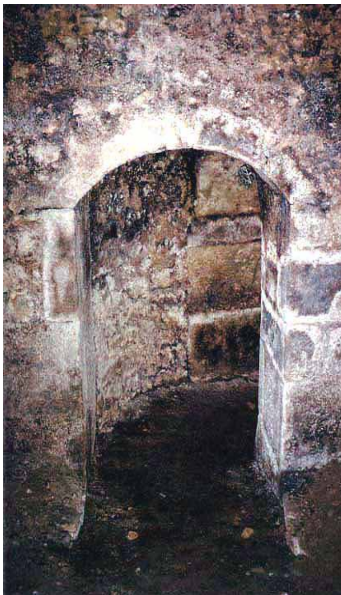
Manzana 1.-C/ Dolores Saíz de Tapia nº 9 (M 1-l). Arco escarzano en sillería de acceso al Calado 4.
