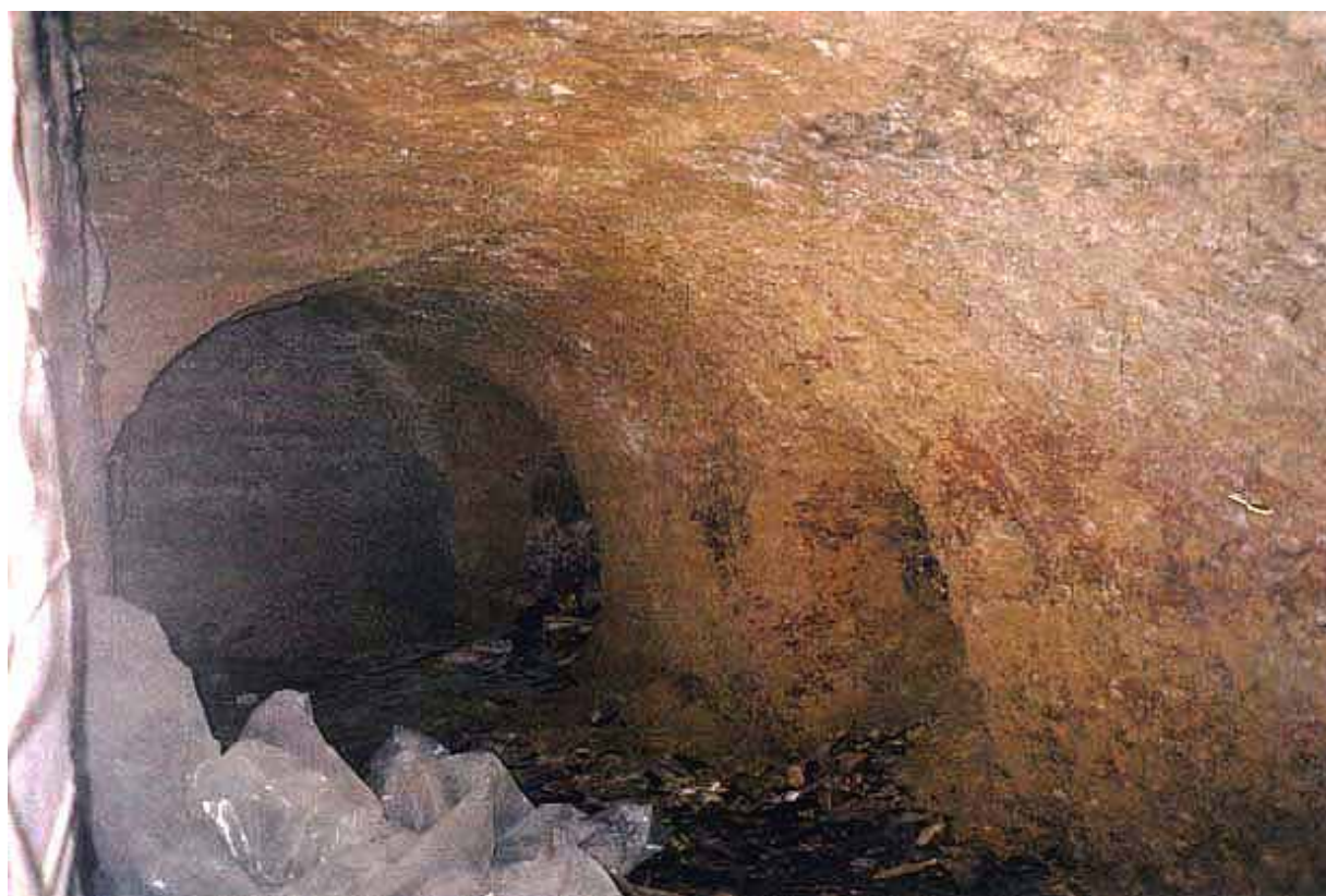
Manzana 18.- C/ Rua Mayor de Peralta nº 5. (M 18- C). Calado carente de estructuras de refuerzo.
