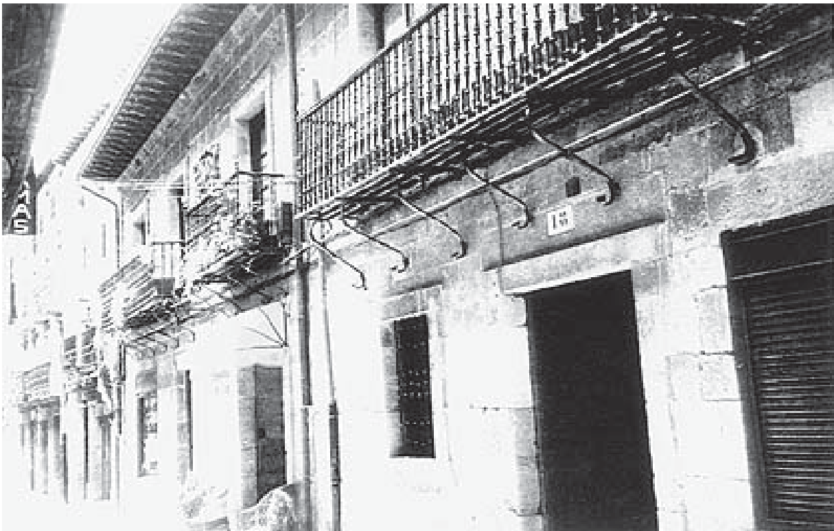
C/ Mayor de Miguleoa nº 18 y nº 20 (M 6-H/I)
