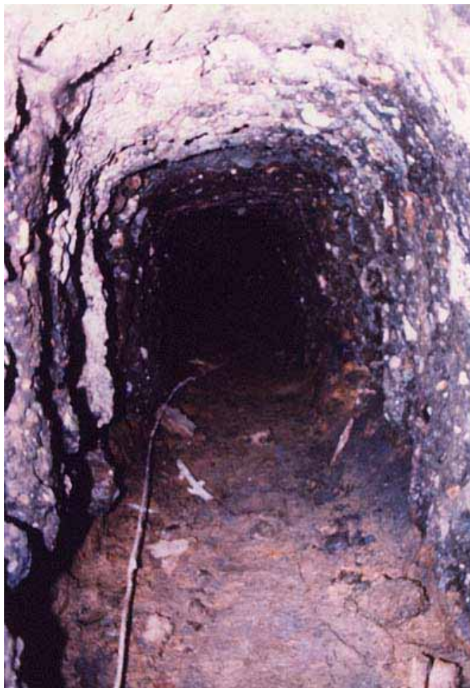
Galería excavada en yesos de la Mina de Botana
