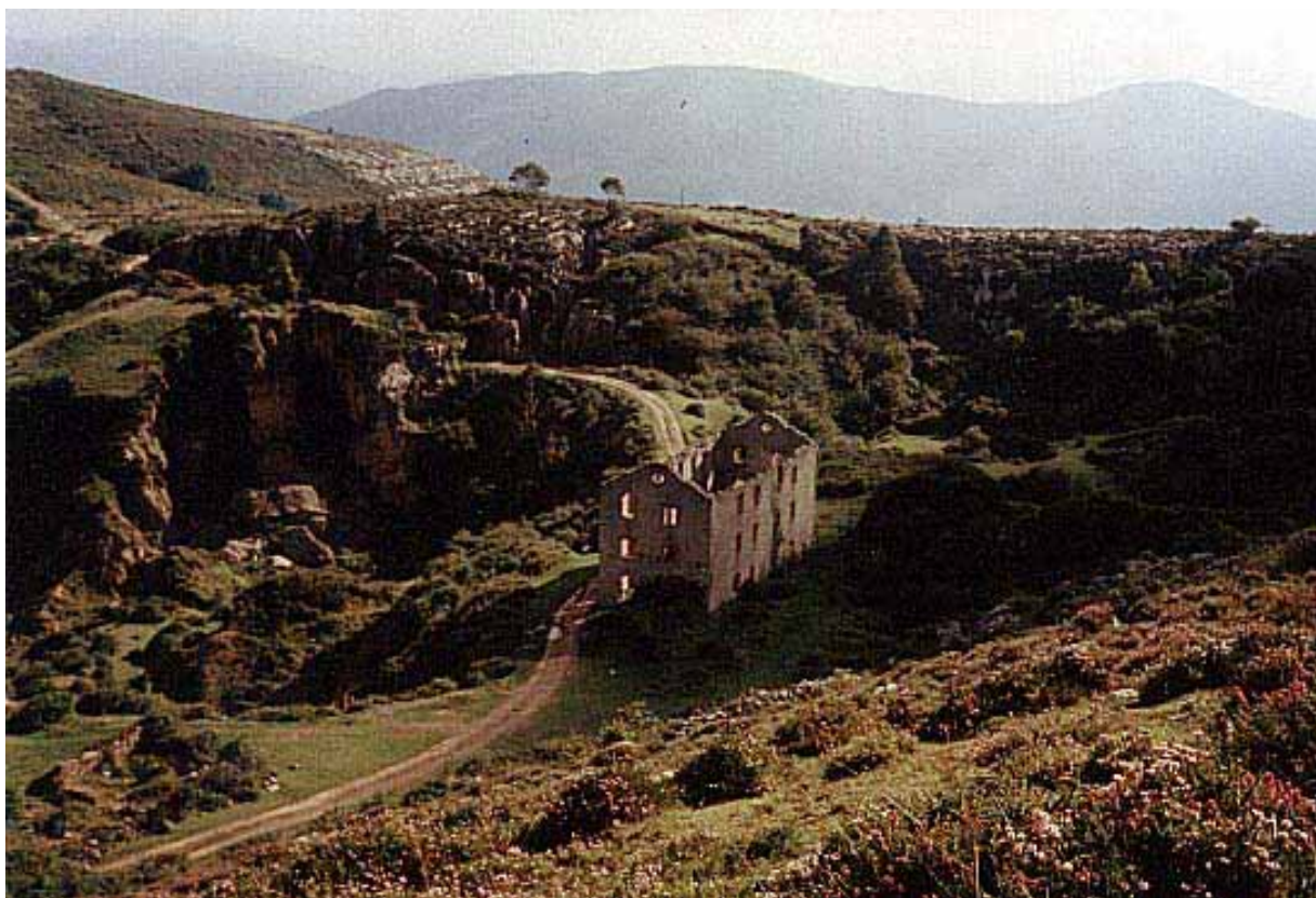
Detalle de una de las casas del barrio de Saúco. La cueva se desarrolla bajo ella, aproximadamente. Esas grietas a la izquierda corresponden al antiguo filón de mineral.
