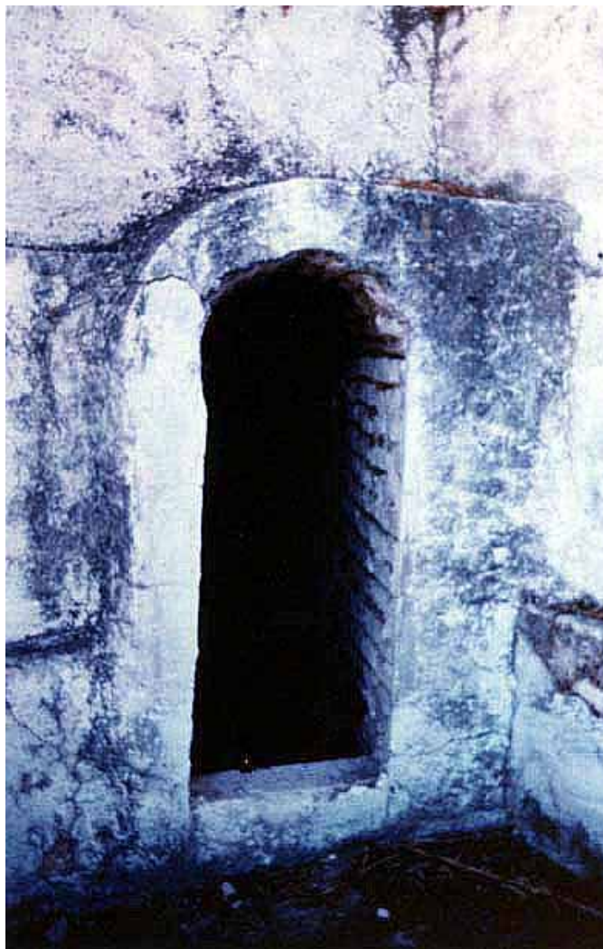
Entrada de la mina de la Casería de Mantas
