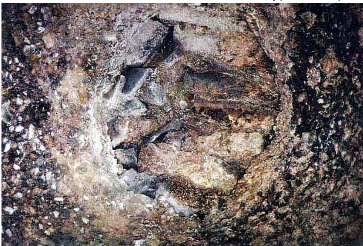
Manzana 1- C/ Dolores Saíz de Tapia nº 7 y nº 9 (M 1-H). Cierre o tapa en mampostería del HOYO 1-H.
