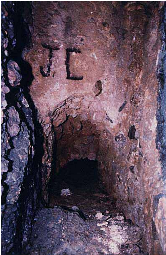
Inicio de la galería revestida en la Mina de Botana
